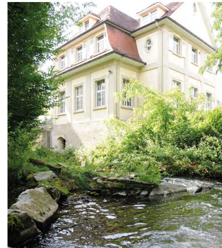
Wasserkraftwerk Josefstraße Gegenüber dem Vorjahr konnte die Erzeugung im Wasserkraftwerk Josefstraße um 30% gesteigert werden.
