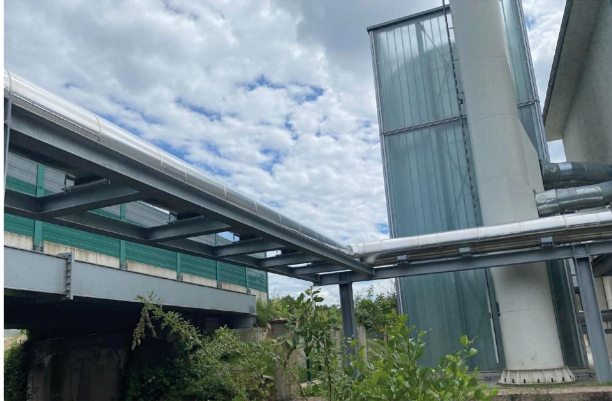
Erweiterung des Nahwärmenetz: Über- und unterirdische Verlegung von 170 Metern Wärmeleitung von der Joffre Heizzentrale für Anschluss des Pflegeheims Kursana. Zur oberirdischen Überquerung des Gewerbekanal wurde eine sogenannte Rohrbrücke gebaut.
