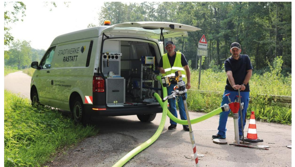
Mit dem mobilen Spülfahrzeug können Wasserproben entnommen und Reinigungsarbeiten am Trinkwassernetz in Eigenregie erledigt werden - hier beim Leitungscheck in Ottersdorf im Juli 2021.
